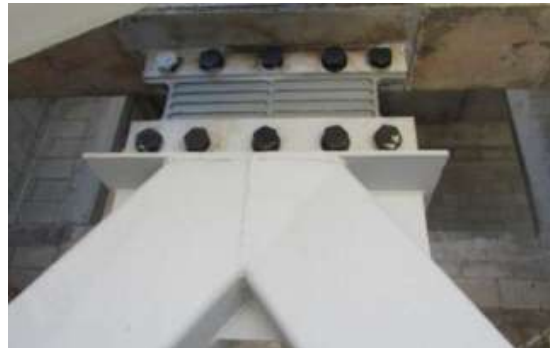
Figura 1. Disipador SLB [4]
