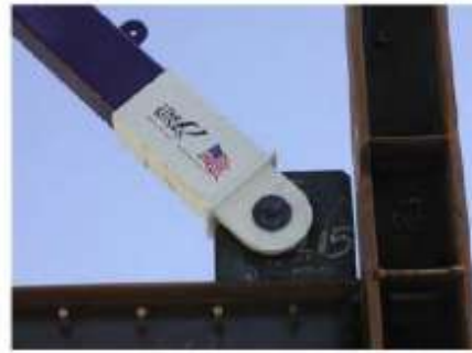
Figura 9. Conexión articulada por pasador [14]
