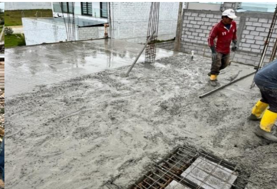
Figura 15. Extendido y vibrado del hormigón.
