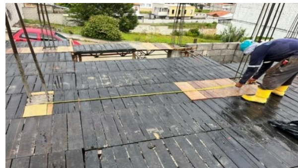
Figura 11. Trazo para colocación de nervaduras y vigas.
