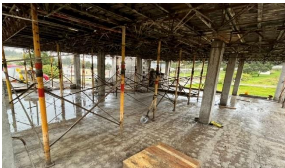
Figura 10. Cimbra o encofrado.
