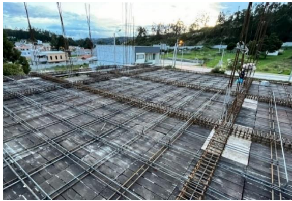
Figura 12. Armado de acero de refuerzo.
