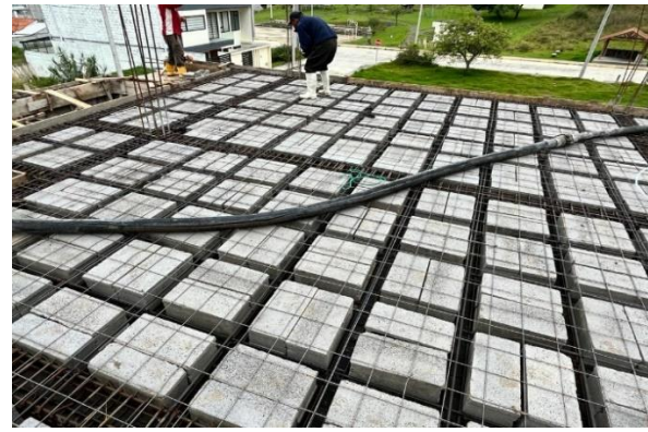
Figura 13. Colocación de bloque pómez y malla.
