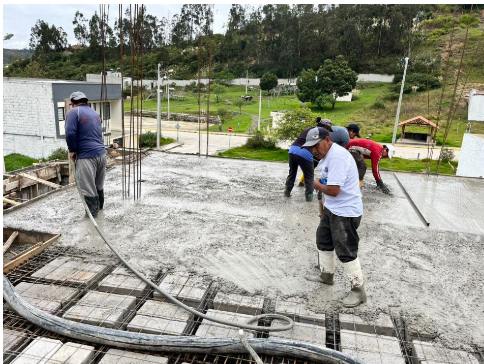
Figura 3. Proceso de Fundición de la losa alivianada con bloque pómez en la ciudad de Azogues.
