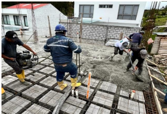
Figura 14. Fundición de losa y vigas con hormigón.
