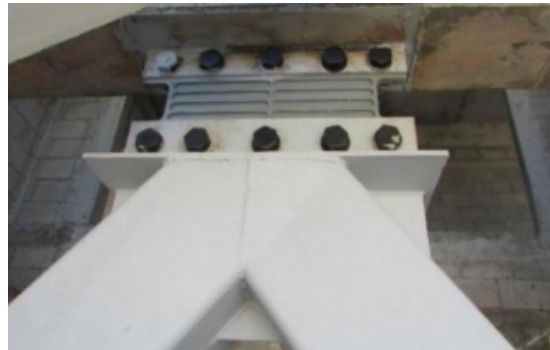
Figura 1. Disipador SLB [4]
