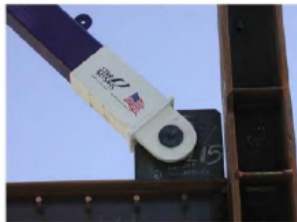
Figura 9. Conexión articulada por pasador [14]
