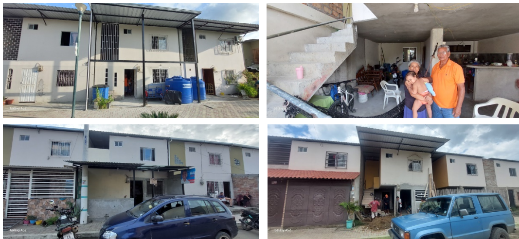
Figura 18. Crecimiento progresivo desordenado y sin control en Etapa II
