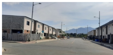
c). VIVIENDAS ETAPA 3
