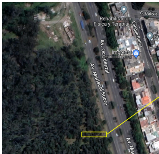
Figura 2. Sección crítica 5 del talud con alto nivel de deterioro y deslizamientos localizados previos.
