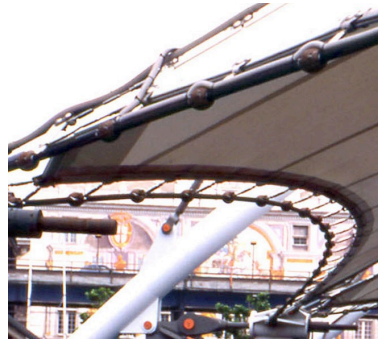
Figura 8. Apoyo de fijación tipo lineal [17].
