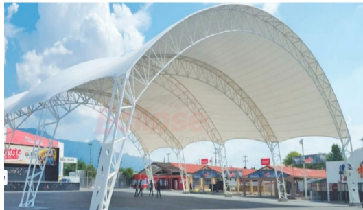
Figura 3. Cubierta tensada forma de arco [12].
