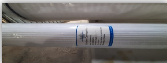
Ilustración 1 Fig. 1. Filtro Plisado 40" 1 \mu m.
