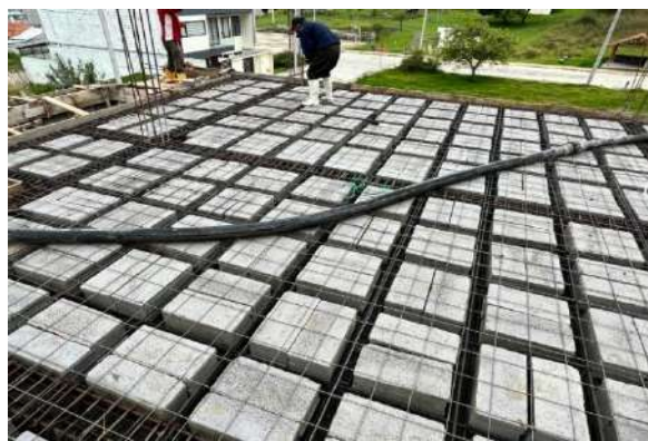
Figura 13. Colocación de bloque pómez y malla.
