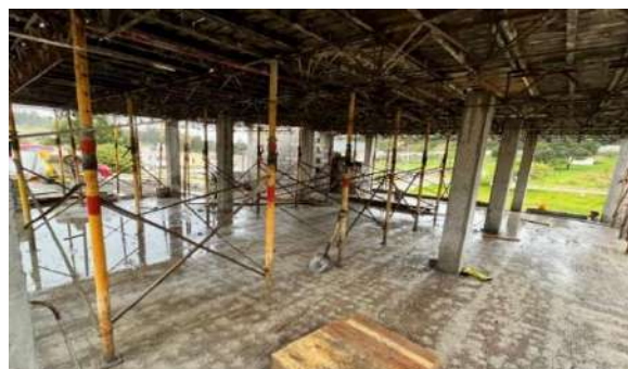
Figura 10. Cimbra o encofrado.
