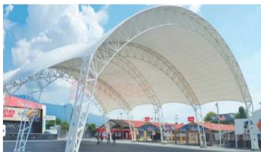
Figura 3. Cubierta tensada forma de arco [12].
