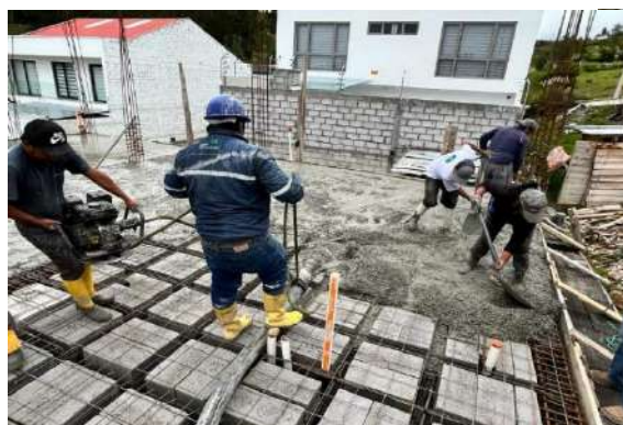
Figura 14. Fundición de losa y vigas con hormigón.
