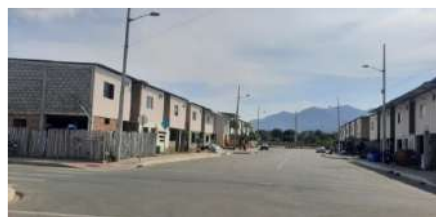
c). VIVIENDAS ETAPA 3
