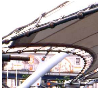
Figura 8. Apoyo de fijación tipo lineal [17].
