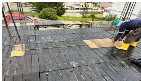
Figura 11. Trazo para colocación de nervaduras y vigas.
