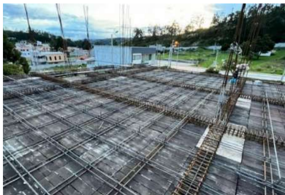
Figura 12. Armado de acero de refuerzo.
