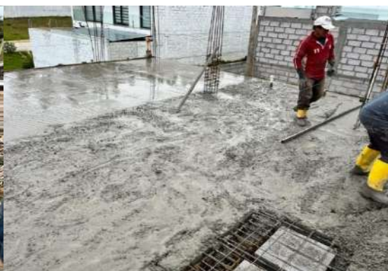
Figura 15. Extendido y vibrado del hormigón.
