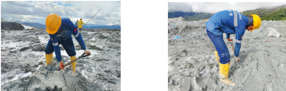
Figura 9. Postura del trabajador durante el retacado de barrenos.
