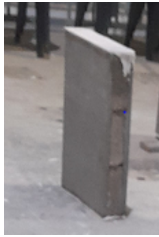
Figura 5. Prismas con bloques de hormigón.
