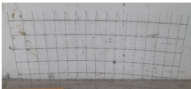
Figura 3. Malla de acero.
