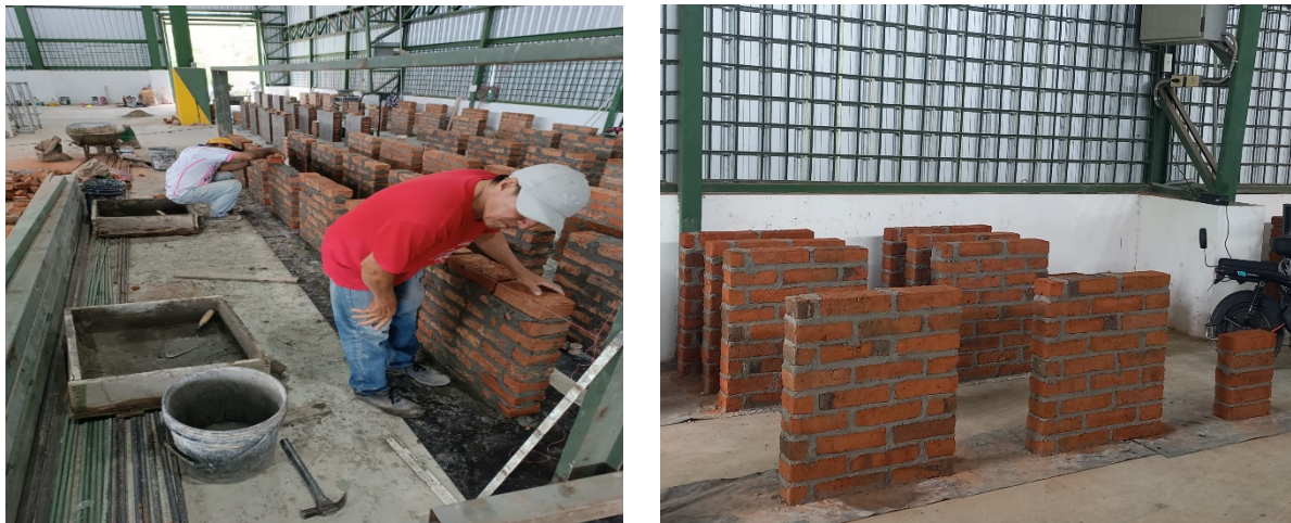
Figura 5. Proceso de Elaboración de muretes y prismas.
